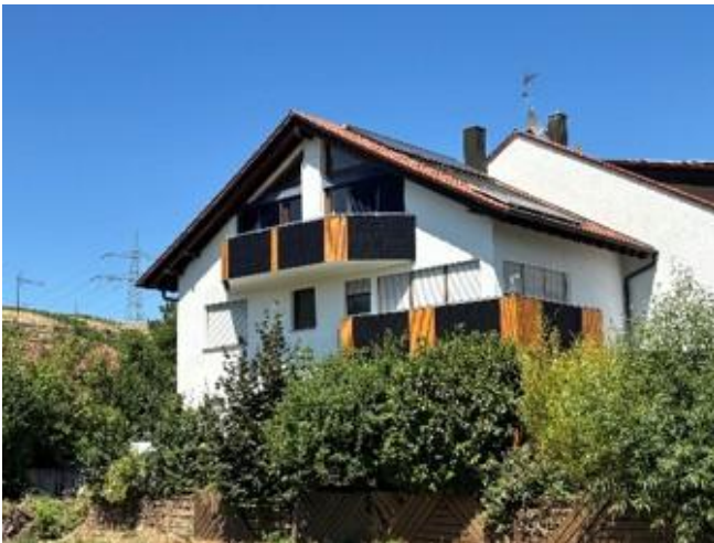
Bild 1: Seit Juli 2025 wird die Doppelhaushälfte überwiegend per Luft-Luft-Wärmepumpe beheizt. An kalten Wintertagen ergänzt ein Kaminofen die Wärmeversorgung. Bildquelle: FGK e. V.
